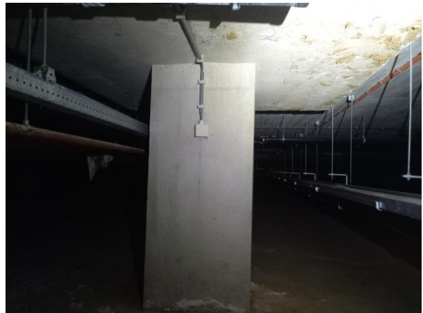
Rond de kolommen in de kruipruimte zijn geen asbestverdachte materialen aangetroffen.
