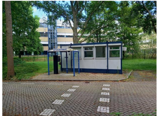
In en rond de portocabin zijn geen asbestverdacht materialen aangetroffen.
