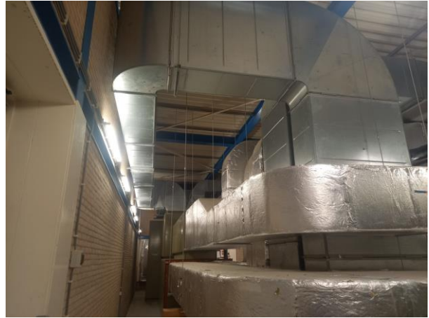
De aangetroffen LBK zijn niet asbestverdacht.
