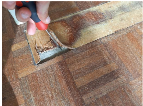
Onder de houten parket vloer zijn geen asbestverdachte materialen aangetroffen.
