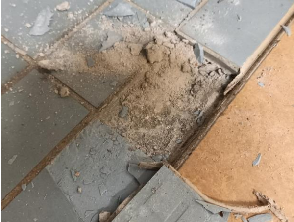
Onder de vloertegels in de natte ruimtes zijn geen asbestverdachte materialen aangetroffen.
