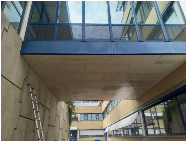
Het plafond van de loopbrug is uitgevoerd in hout.
