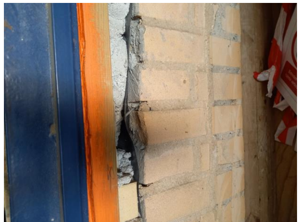
In de spouwmuur zijn geen asbestverdachte materialen aangetroffen.
