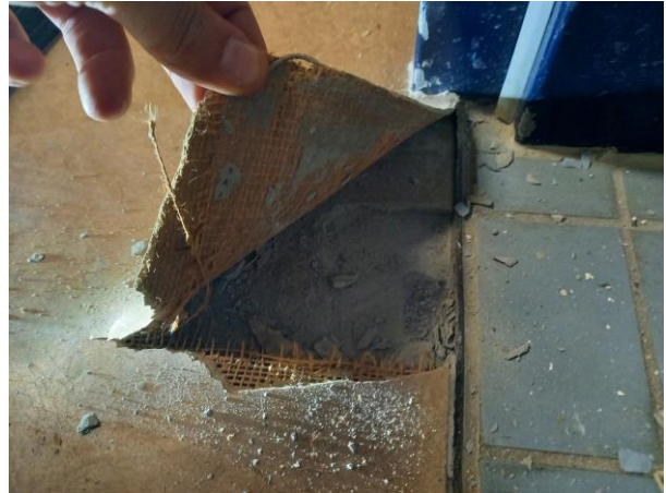
Onder het linoleum zijn geen asbestverdachte materialen aangetroffen.
