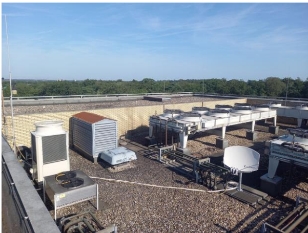
Op het dak zijn geen asbestverdachte materialen aangetroffen.
