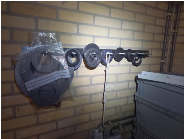
De pakkingen die op voorraad worden gehouden zijn niet asbestverdacht.
