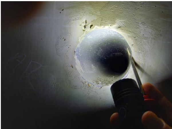
Het buismateriaal in de kruipruimte is uitgevoerd in PVC.
