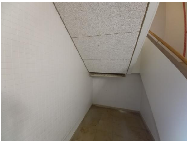
Achter en rond de houtwolcementplaten zijn geen asbestverdachte materialen aangetroffen.
