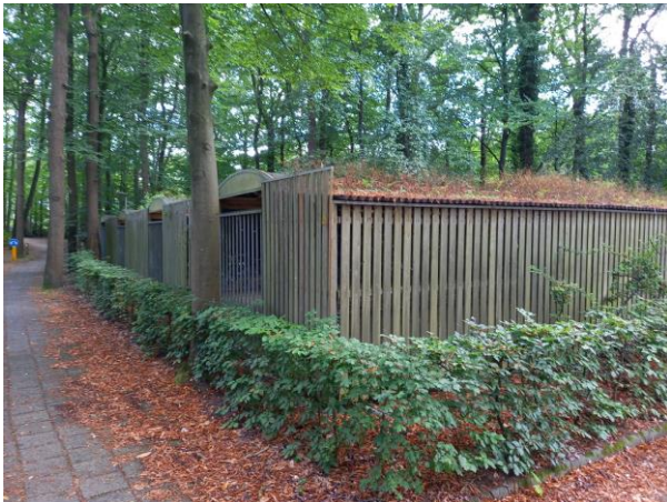
In en rond de fietsenstalling zijn geen asbestverdachte materialen aangetroffen.
